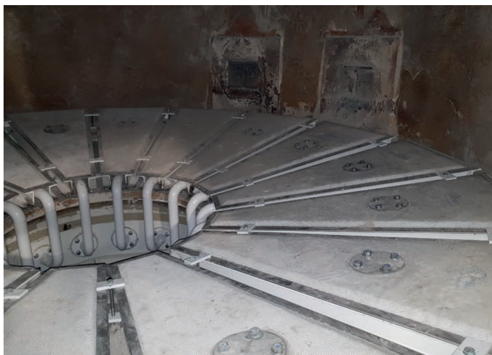
Afb. 1 De onderzijde en bovenzijde (hieronder) van een silo beluchtingsbodem
